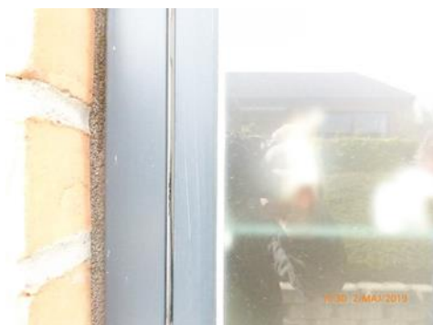
3.3 – Tilstand fugebånd
