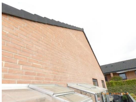
2.3 – Oversigt gavlmurværk, bolig nr. 64
