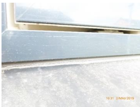
3.4 – Tilstand elastisk fuge under bundkarm
