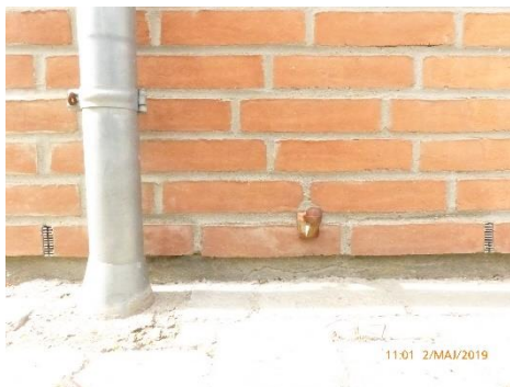
4.2 – Revne i sokkelpuds ved facade
