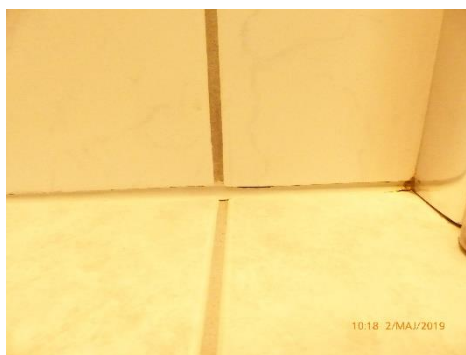
5.6 – Elastisk fugeslip i bruseniche i bolig nr. 64
